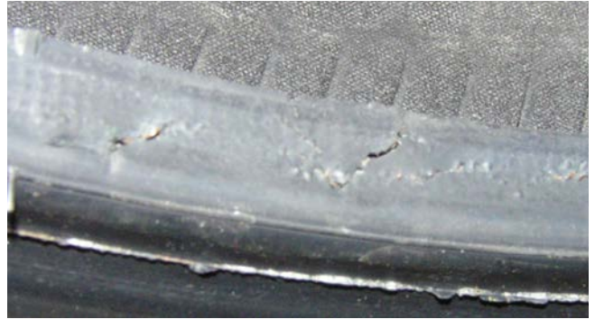
2.3.1 – Rissbildung in der Wulst
